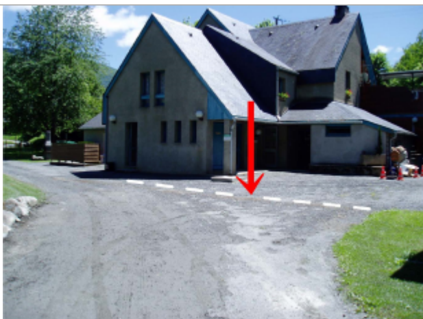
Laisse de crue
