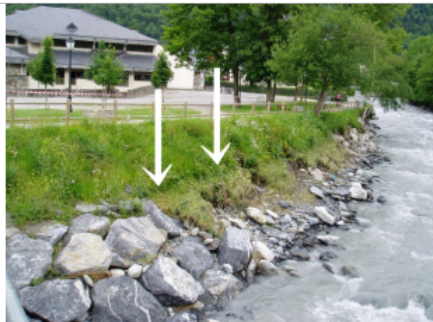
Limite de la crue au seuil de débordement
