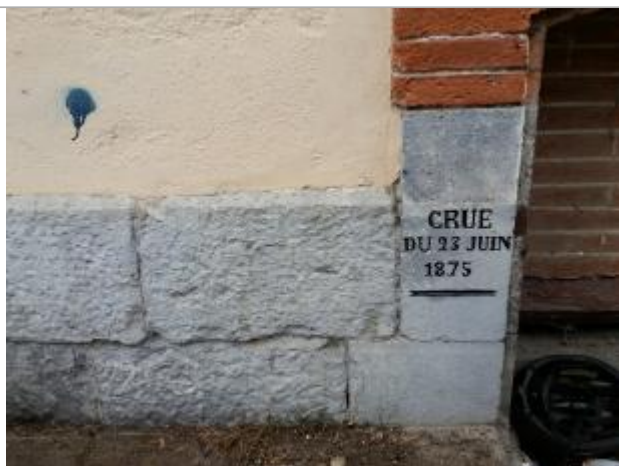
repère restaurée en 2022
