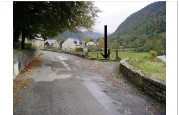
Débris dans le grillage
