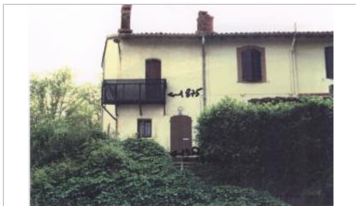
(24174) Commune de Noé (RG) : Ancienne maison du passeur Laisse de crues de 1875 (182,60 mNGF) et 1952 (179,68 mNGF)
