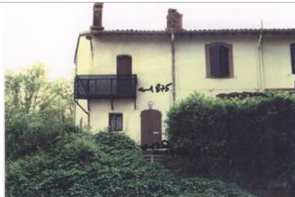
(24174) Commune de Noé (RG) : Ancienne maison du passeur Laisse de crues de 1875 (182,60 mNGF) et 1952 (179,68 mNGF)
