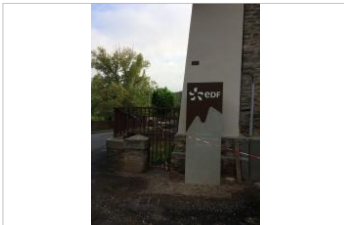
vue de la facade sud le l'usine hydro electrique
