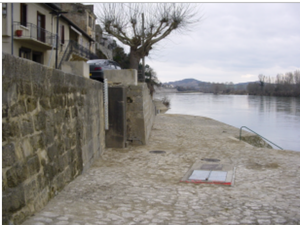
Echelle SPC quai de Tonneins
