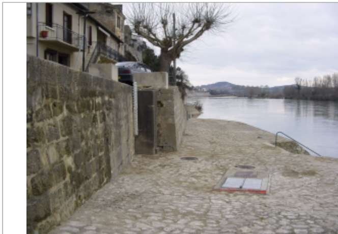
Echelle SPC quai de Tonneins
