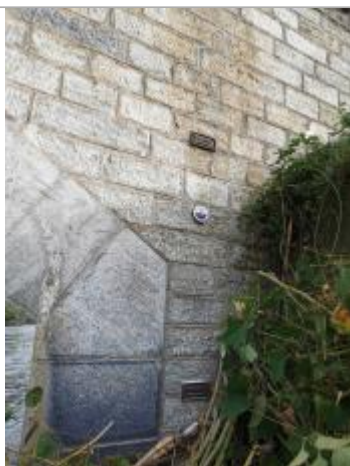
Repère normalisé au dessus du repère de 1897
