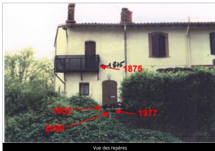
Vue des repères
