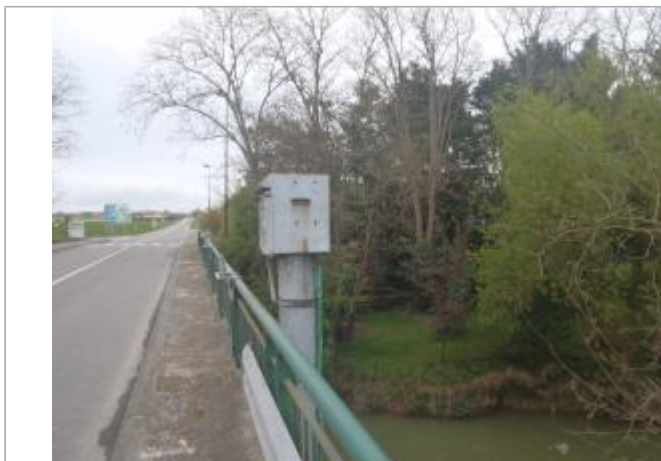
Vue de la station limnimétrique
