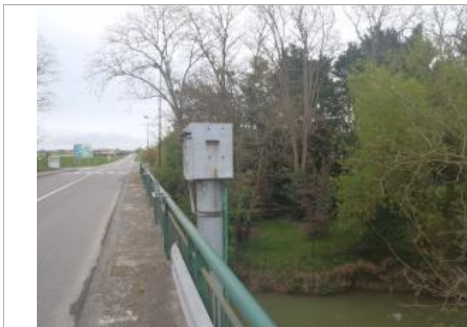
Vue de la station limnimétrique
