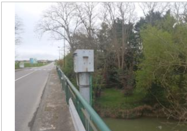
Vue de la station limnimétrique
