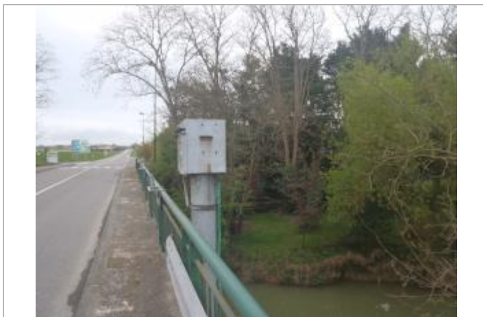
Vue de la station limnimétrique
