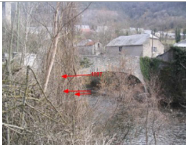
Repères des crues de 1897, 1982 et de 2001
