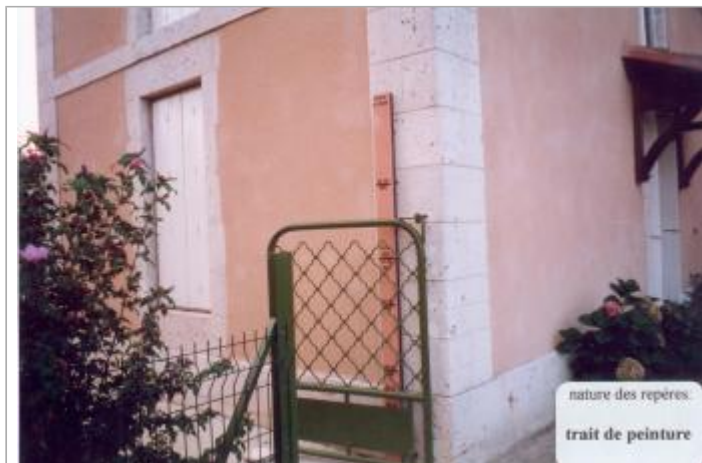
Photo des repères
