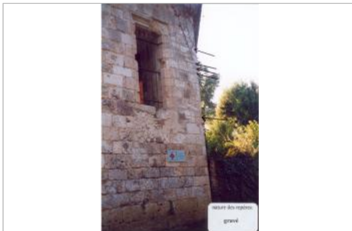
Photo des repères
