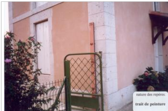
Photo des repères
