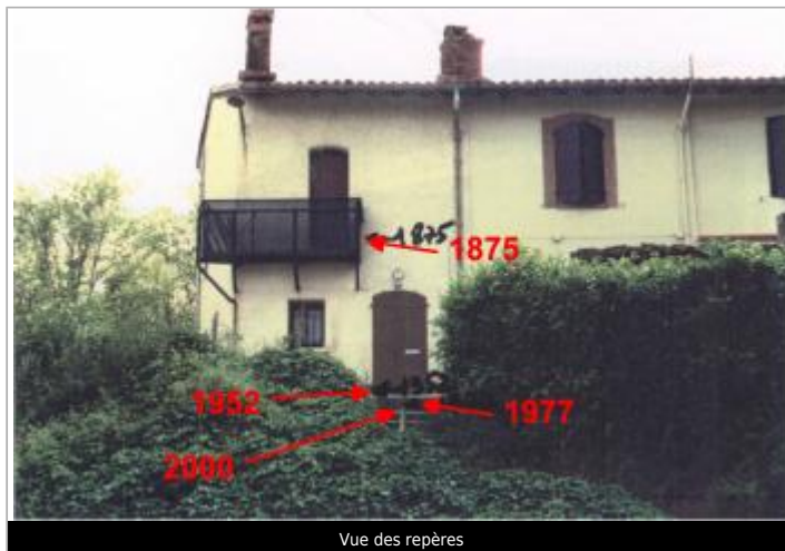
Vue des repères
