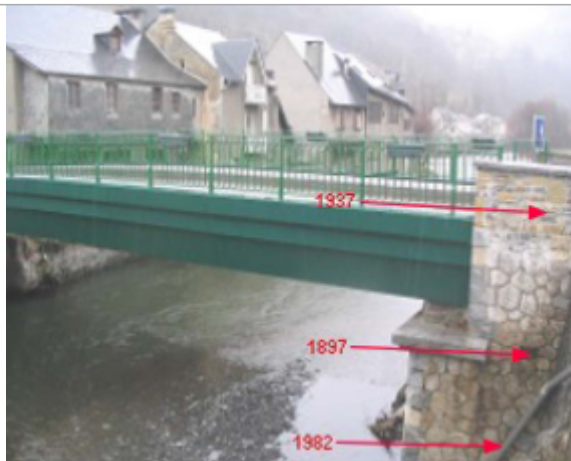
Repères pour les crues de 1897, 1937 et de 1982
