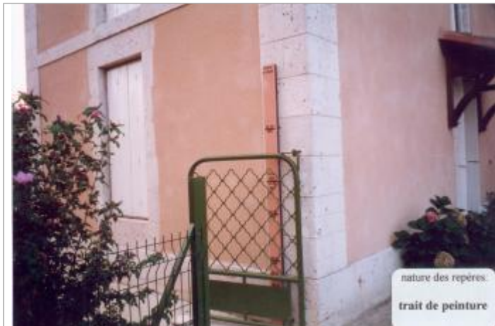
Photo des repères
