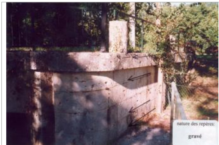
Photo des repères
