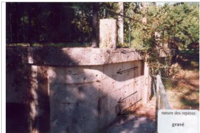
Photo des repères
