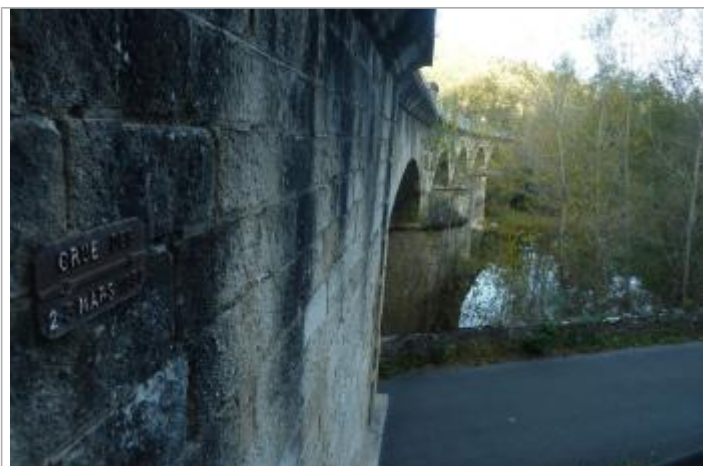
culée pont voie ferrée face amont rive gauche
