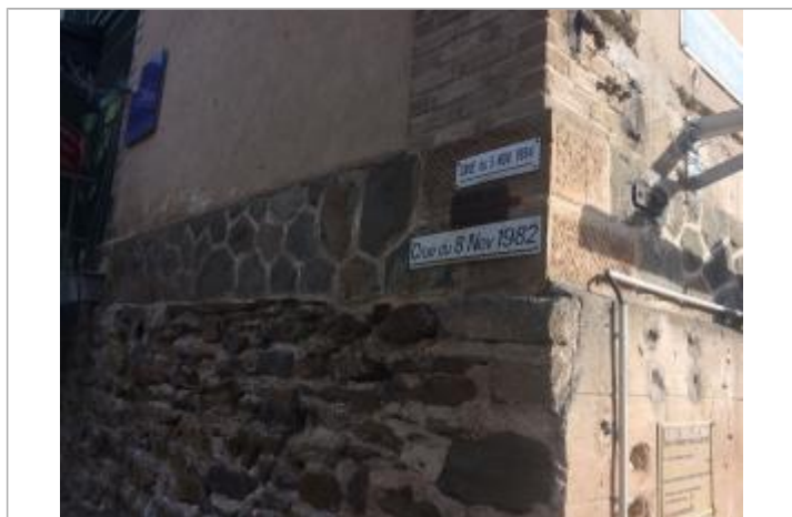
Vue des repères
