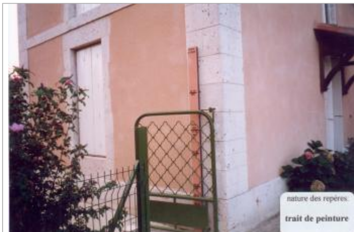
Photo des repères
