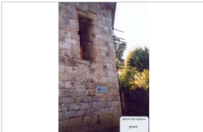
Photo des repères
