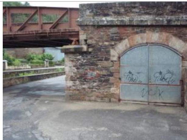
Photo culée droite du pont © EPAGE VIAUR
