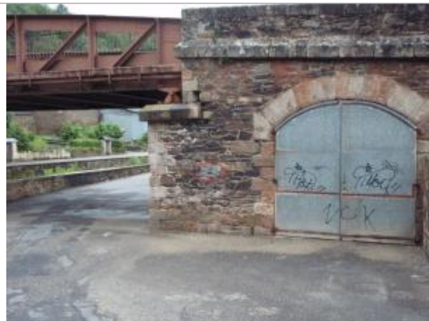
Photo culée droite du pont © EPAGE VIAUR
