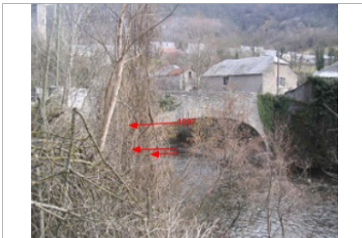
Repères des crues de 1897, 1982 et de 2001
