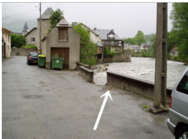
Débris montrant que la crue a frôlé à cet endroit le seuil de débordement
