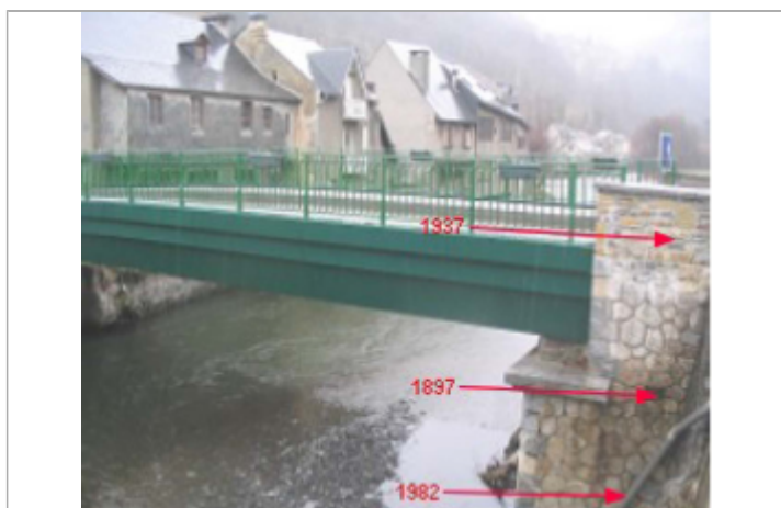
Repères pour les crues de 1897, 1937 et de 1982
