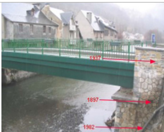
Repères pour les crues de 1897, 1937 et de 1982
