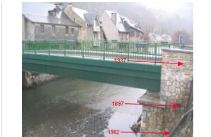
Repères pour les crues de 1897, 1937 et de 1982
