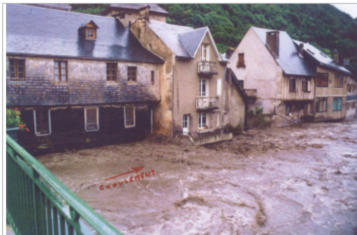
Vue sur la Neste en aval de l'ancien pont de Sarrancolin
