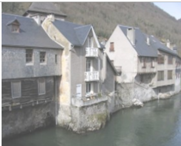
En 2001 - l'eau est arrivée au niveau du rebord inférieur du balcon.
