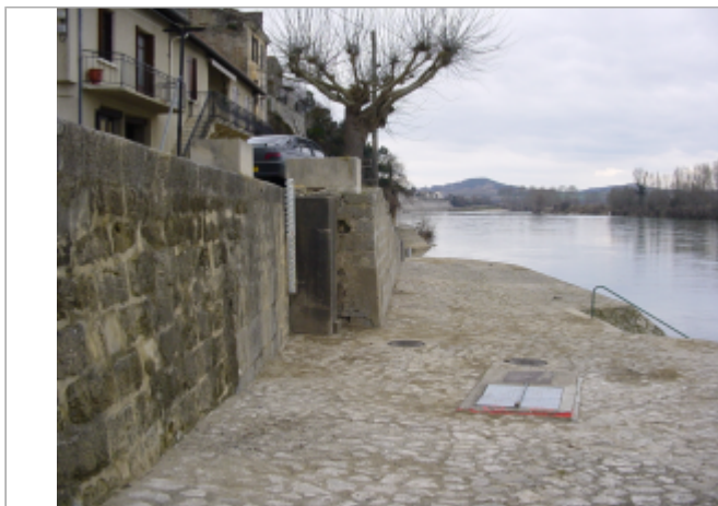
Echelle SPC quai de Tonneins
