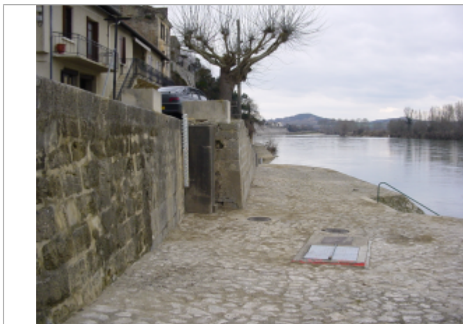
Echelle SPC quai de Tonneins
