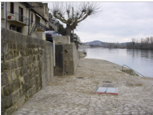
Echelle SPC quai de Tonneins
