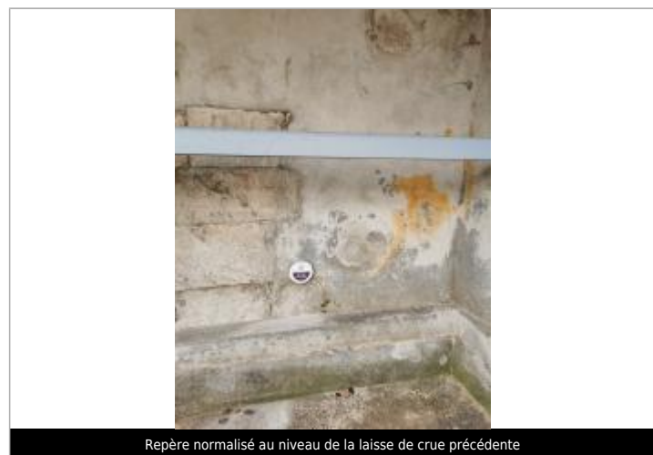
Repère normalisé au niveau de la laisse de crue précédente
