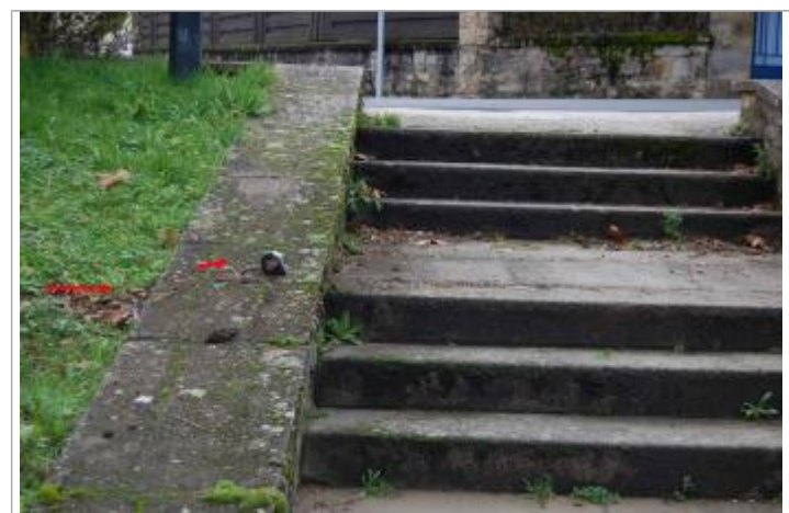
Vue de la laisse d'inondation - Auteur : GEOSPHAIR
