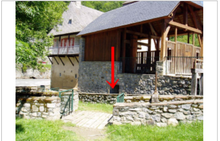
Trace de crue
