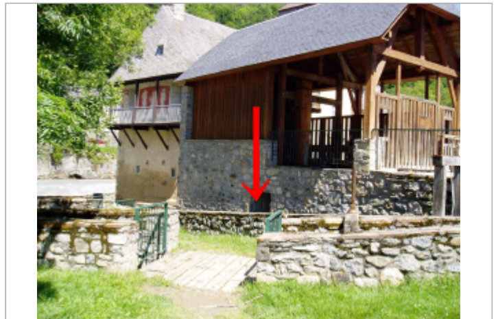
Trace de crue
