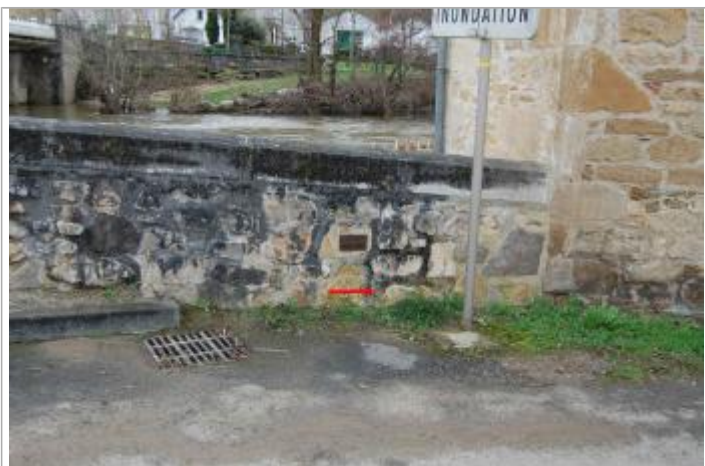
Vue de la laisse d'inondation - Auteur : GEOSPHAIR
