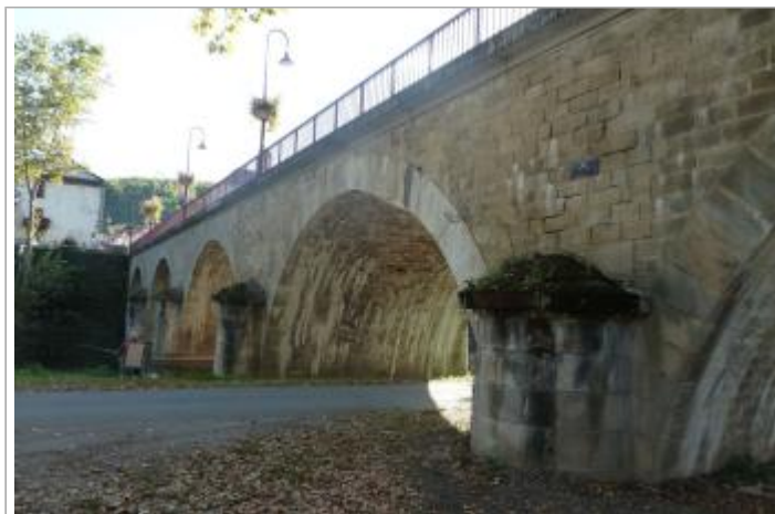
pont RD958 face amont rive droite
