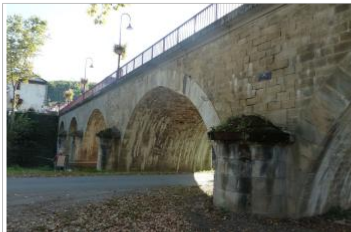
pont RD958 face amont rive droite
