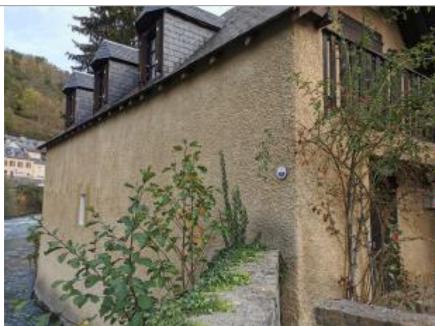
Positionnement du repère sur la face visible depuis la route et depuis la place surplombant la Neste.
