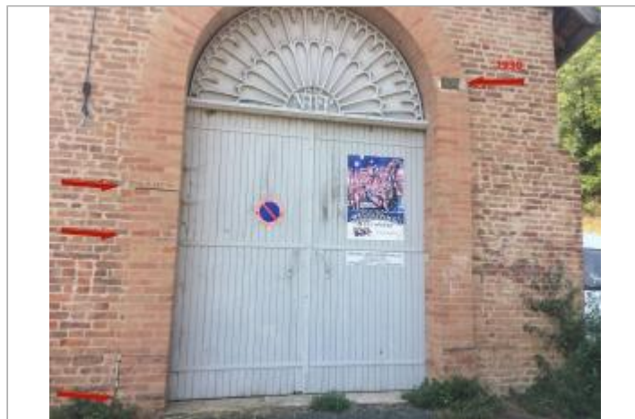
Vue des repères
