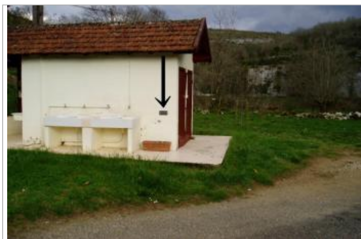
Ancien sanitaire du camping -DDT46
