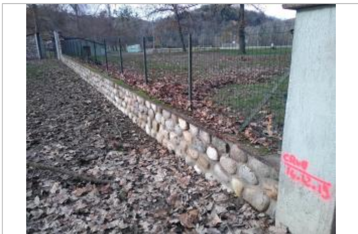
Hauteur atteinte au niveau du haut du muret de clôture
