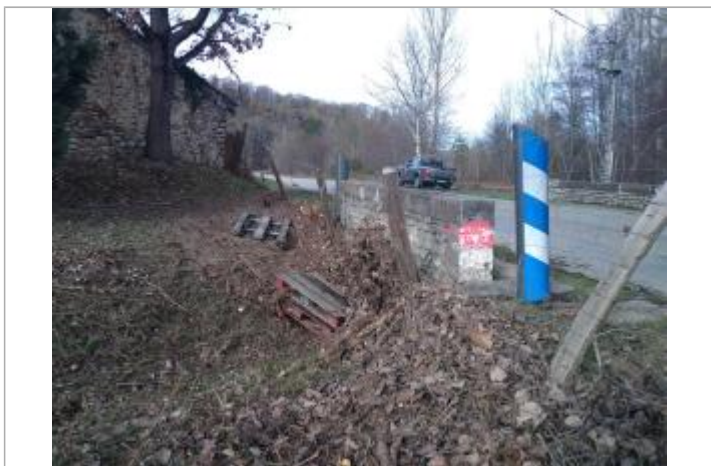
Marques relevées sur la rambarde de la RD119
