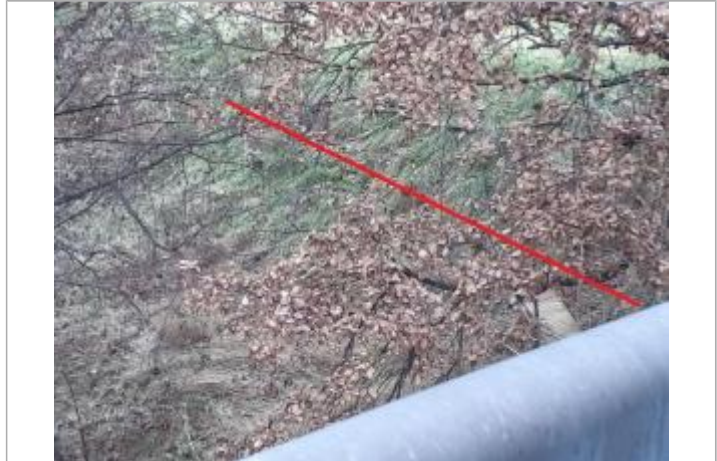
Laisse sur berge rive droite aval de la passerelle
