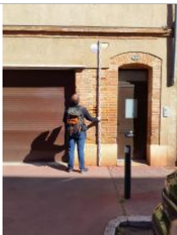
Photo du repère - mesure 2,88 m
