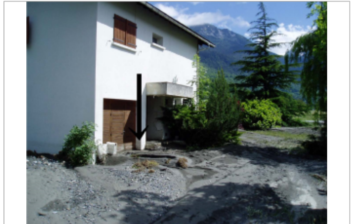
Trace de la crue
