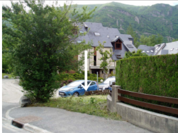
Débris dans le grillage
