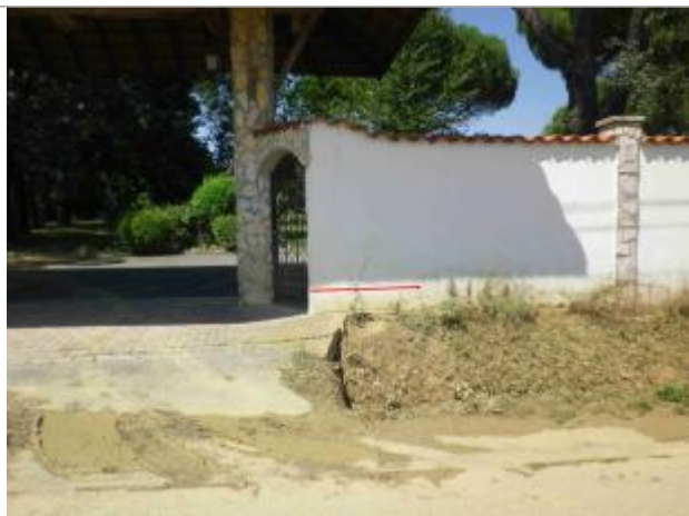
Vue de la laisse d'inondation - Auteur : GEOSPHAIR
