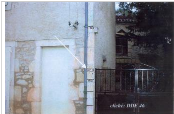
Photo des repères
