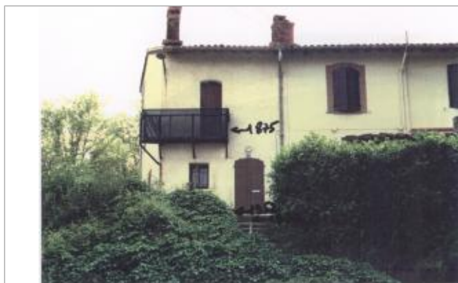
(24174) Commune de Noé (RG) : Ancienne maison du passeur Laisse de crues de 1875 (182,60 mNGF) et 1952 (179,68 mNGF)
