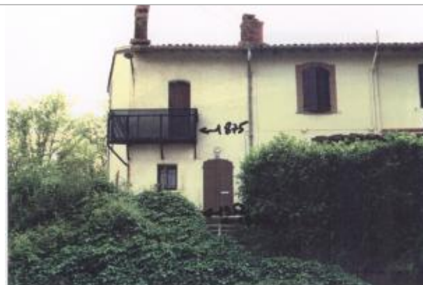
(24174) Commune de Noé (RG) : Ancienne maison du passeur Laisse de crues de 1875 (182,60 mNGF) et 1952 (179,68 mNGF)
