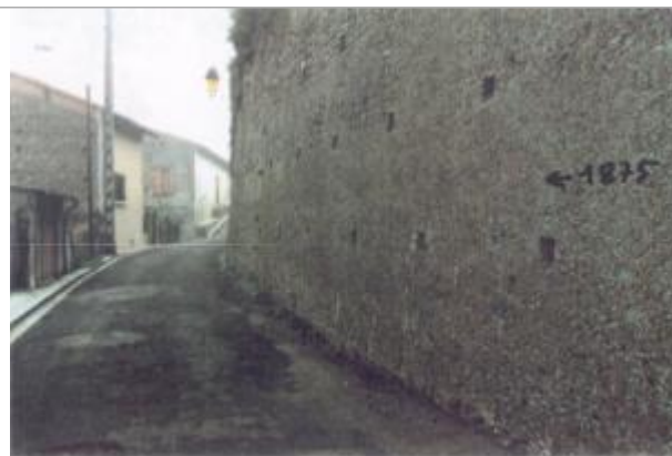
(24419) Commune de Capens (RD) : Laisse de crue de 1875 (187,60 mNGF)
