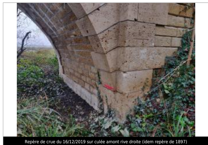
Repère de crue du 16/12/2019 sur culée amont rive droite (idem repère de 1897)
