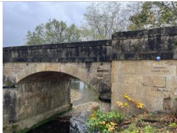
Photo du site pont RD 62 sur Ruisseau du Lens
