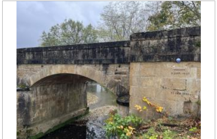
Photo du site pont RD 62 sur Ruisseau du Lens
